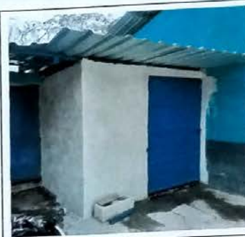
Foto 2: MODULO B Servicio Sanitario. Vista exterior Acabado en muros, suministro e instalación de puerta de metal y Colocación de costaneras de metal y lamina troquelada cal 26.
