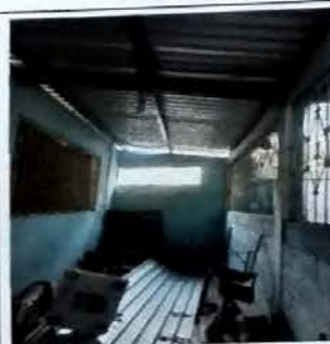
Foto 5: MODULO B Suministro e instalación de estructura de metal a base de costaneras e instalación de lamina troquelada cal 26.
