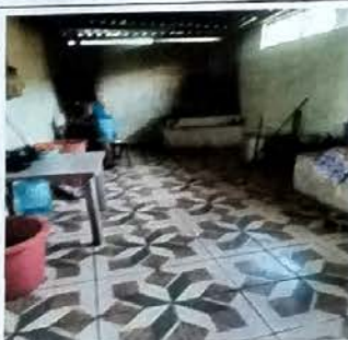
Foto 9: Suministro e instalacion de piso ceramico en area de cocina
