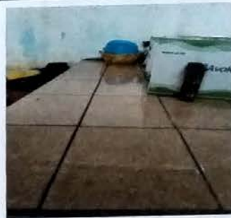
Foto 10: Modulo de Cocina ejecucion de mueble de concreto con aplicacion de azulejo en muros y superficie.
