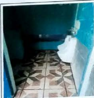
Foto 3: MODULO A Servicio Sanitario. Suministro e instalación de piso cerámico + instalación de urinarios individuales con aplicación de azulejo en urinario colectivo existente.
