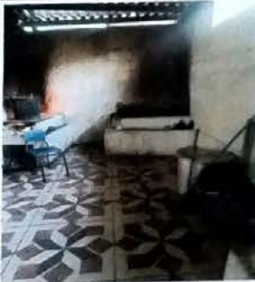
Foto 9: Suministro e instalacion de piso ceramico en area de cocina
