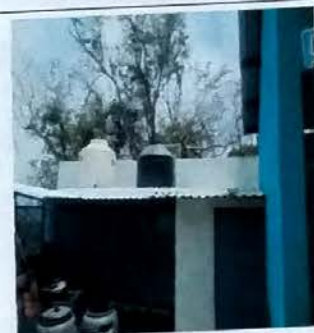
Foto 2: MODULO B Servicio Sanitario. Vista exterior Acabado en muros, suministro e instalación de puerta de metal y Colocación de costaneras de metal y lamina troquelada cal 26.
