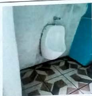
Foto 3: MODULO A Servicio Sanitario. Suministro e instalación de piso cerámico + instalación de urinarios individuales con aplicación de azulejo en urinario colectivo existente.
