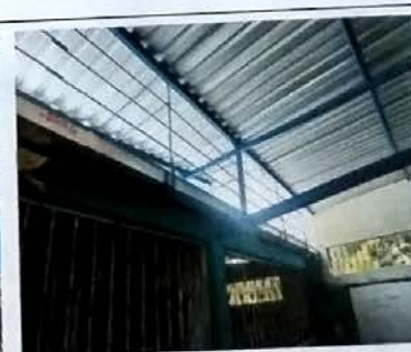
Foto 4: MODULO B Suministro e instalación de 'piso Cerámico mas mantenimiento de balcones en vanos de ventatas. Suministro e instalación de canal de metal con sus pescantes e instalación de estructura de metal a base de costaneras + lamina troquelada cal 26.
