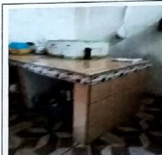
Foto 10: Modulo de Cocina ejecucion de mueble de concreto con aplicacion de azulejo en muros y superficie.
