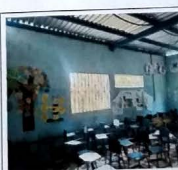
Foto 6: MODULO C Suministro e instalación de lamina troquelada cal 26 + mantenimiento de estructura de metal, apertura de vanos en muros e instalación de balcones de metal.
